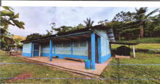
Foto 5: Aplicación de entortado de aulas.
